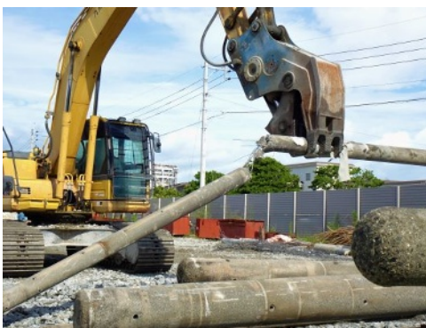
[廃品ポールの破碎処理]
