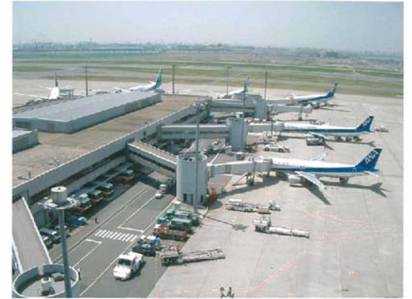
羽田国際空港・西旅客ターミナルビル
