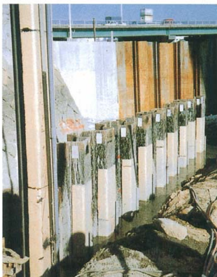
広島 大田川護岸工事 SLシート貼付鋼矢板の打設
